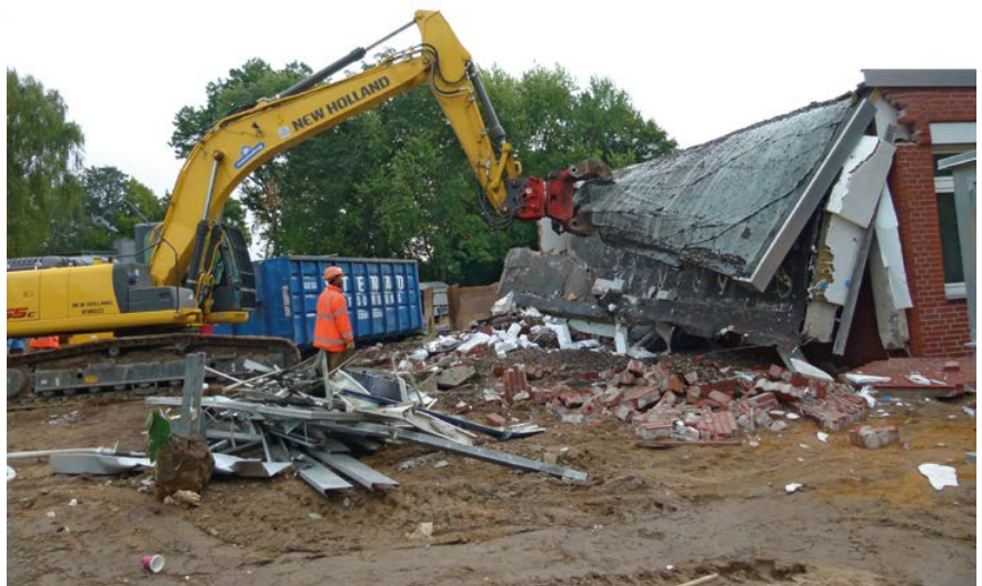
Der Abbruch der früheren orthopädischen Ambulanz im September 2012 schaffte Platz für den Neubau.
