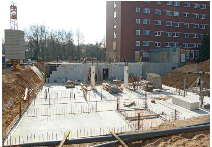
Die Bodenplatte des neuen Facharztzentrums.
