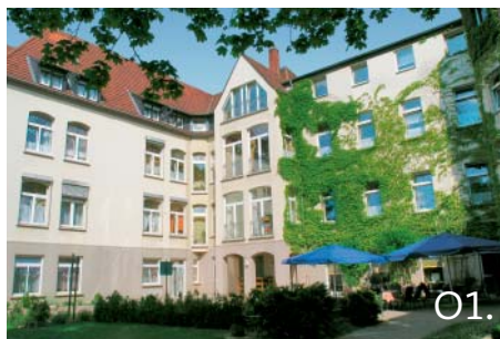
Haus St. Vincenz am Stadtpark in Ahlen.
